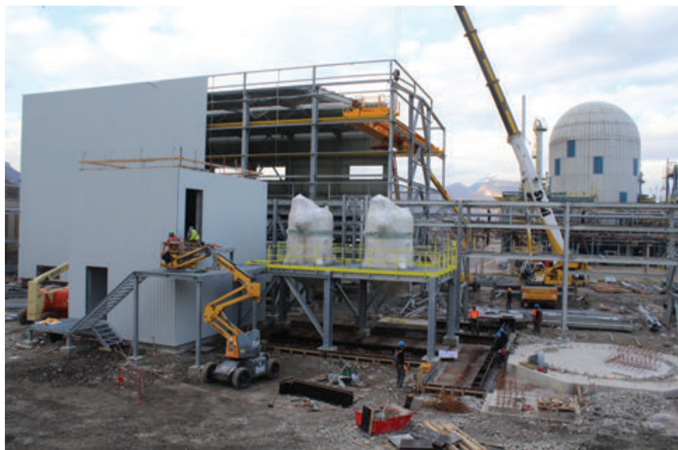
Le nouveau bâtiment de l'atelier chlore en construction (février 2016, photo Vencorex)
