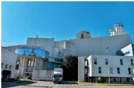
L'usine d'incinération et de valorisation énergétique (UIVE) d'Athanor traite des déchets non dangereux et présente l'intérêt de valoriser l'énergie issue de leur combustion sous forme de chaleur et d'électricité. La chaleur produite alimente le réseau de chauffage urbain de la Métropole.
